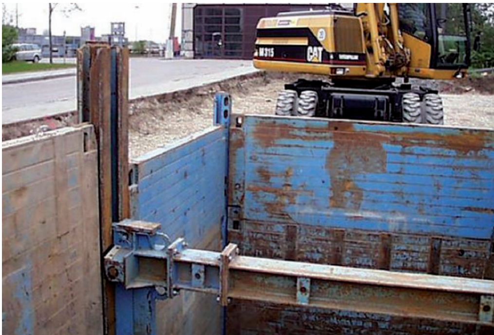
Figura 25 - Blindaggio con rotaie ad angolo (foto)
