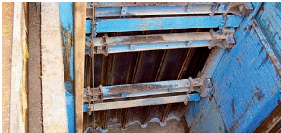
Figura 29 - Blindaggio di testata tramite palancole (foto)
